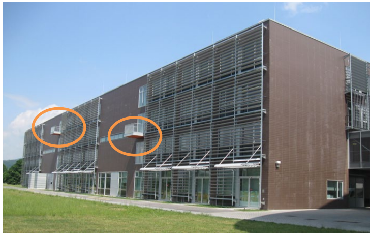
Slika 35: Balkona, namenjena evakuaciji gibalno oviranih oseb
