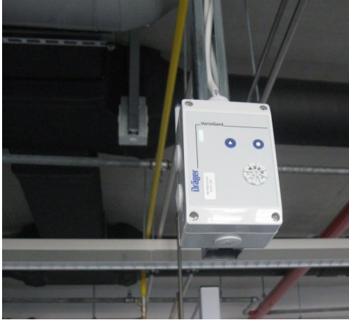
Slika 23: Detektor tehničnega plina
