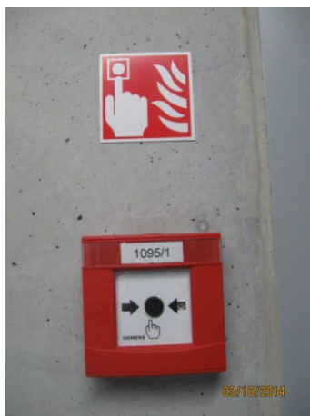
Slika 22: Ročni javljalniki požara
