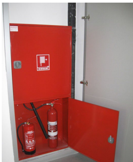
Slika 26: Omara, v kateri so nameščeni hidrant in gasilnika
