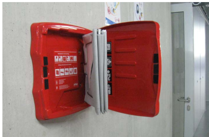
Slika 20: Protipožarna odeja.
