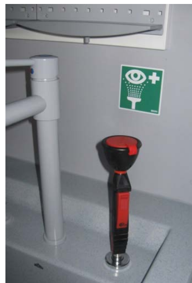
Slika 14: Pipa za izpiranje oči.
