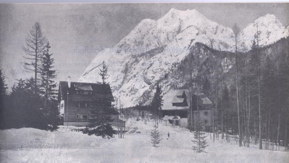
Stari in novi smučarski dom pod Ponco
