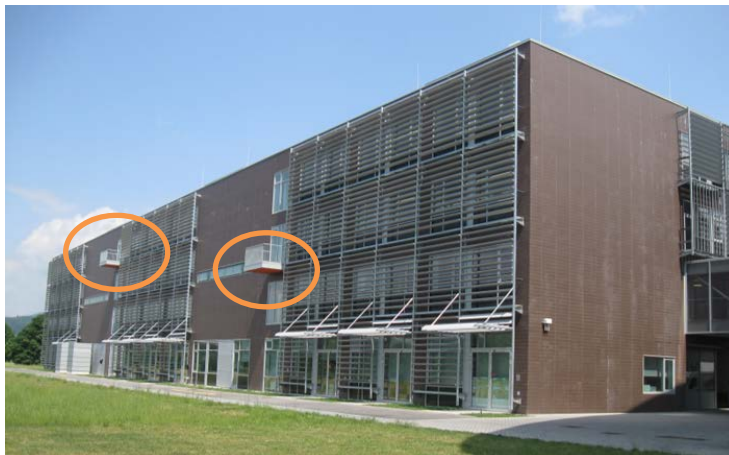
Slika 33: Balkona, namenjena evakuaciji gibalno oviranih oseb
