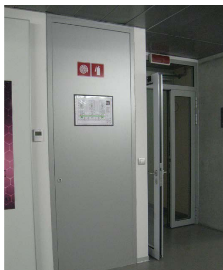
Slika 24: Omara, v kateri so nameščeni hidrant in gasilnika
