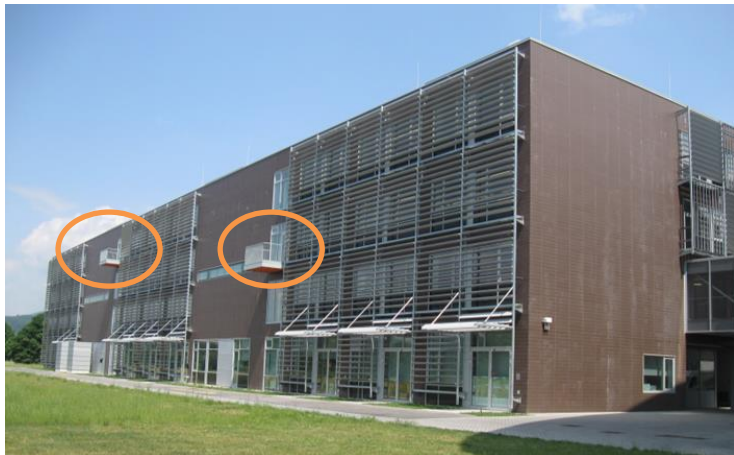
Slika 31: Balkona, namenjena evakuaciji gibalno oviranih oseb
