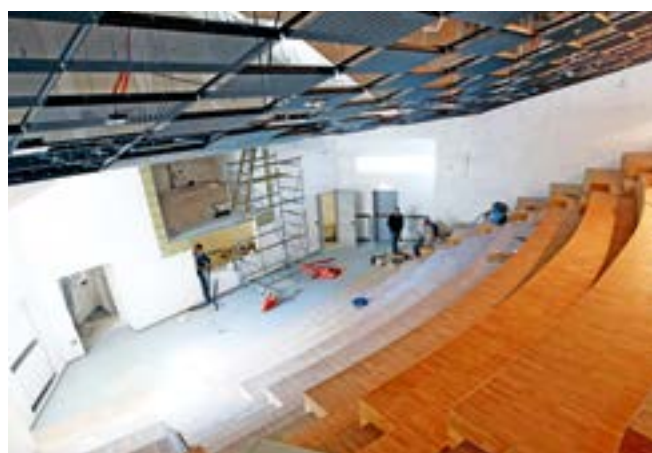
Gradbišče novogradnje UL FKKT in UL FRI (foto: Andrej Križ)
